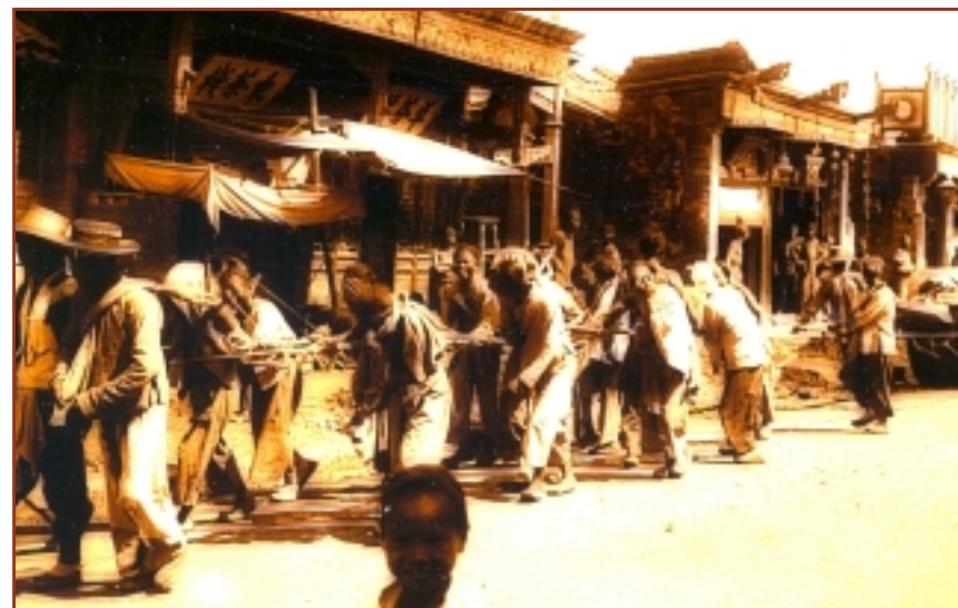
C31 : Travaux de voirie à Pékin
