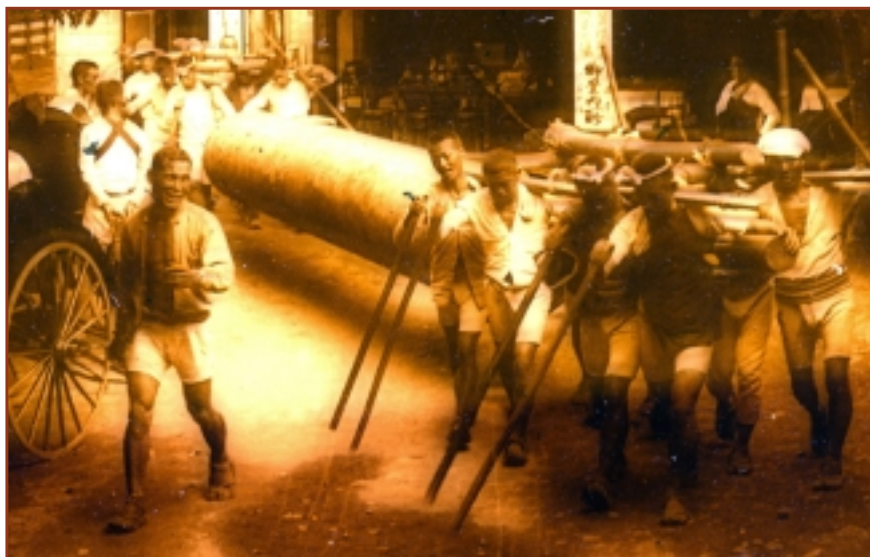
J74 : Transport de canalisation d'égout
